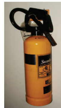
Gambar 1.28 Tabung Pemadam Kebakaran sebagai Salah Satu Perlengkapan Keselamatan Kerja Laboratorium Foto: Dokumentasi Penerbit
