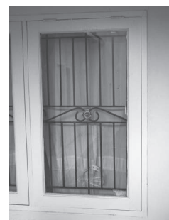
Gambar 5.9 Pemasangan Kaca pada Jendela Perlu Diberi Ruang untuk Pemuaiian Foto: Dokumentasi Pribadi
